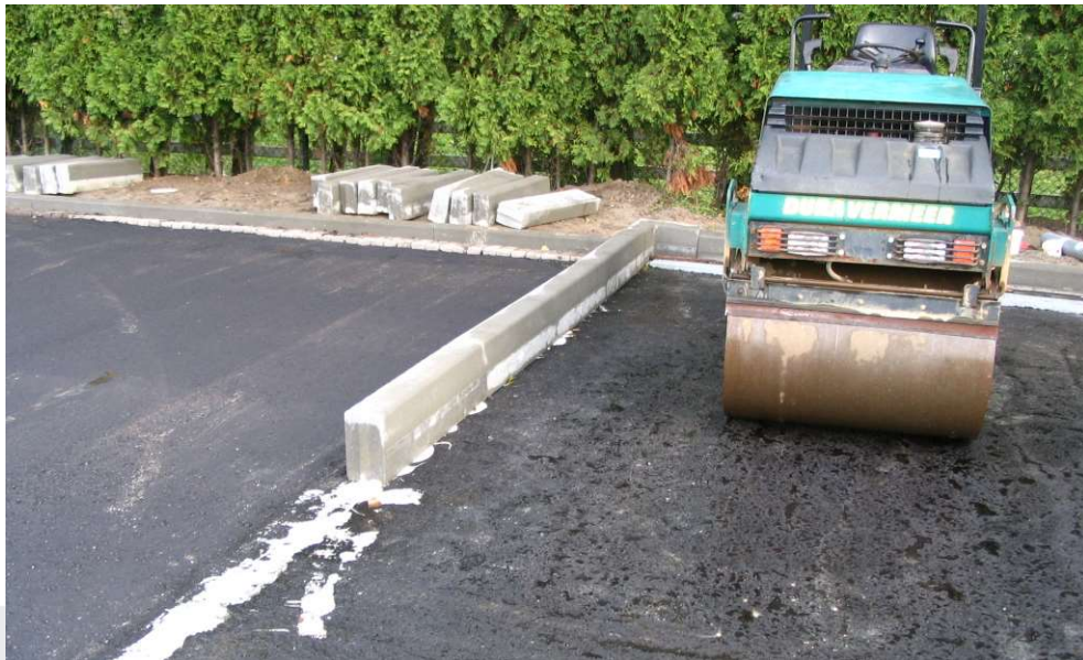
Foto: Verdichten van het asfalt
